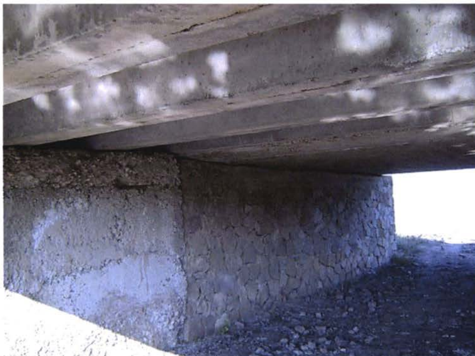
View abutment Nr.1, extended part Vedere culeea Nr.1, partea lărgită Вид устой № 1, уширенная часть
