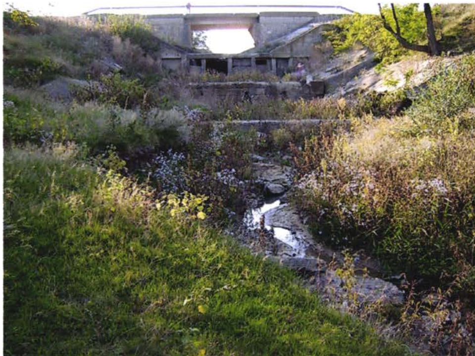
View broadcrested weir (both images) Vedere deversor cu prag lat (ambele imagini) Вид широкого водослива (оба изображения)
