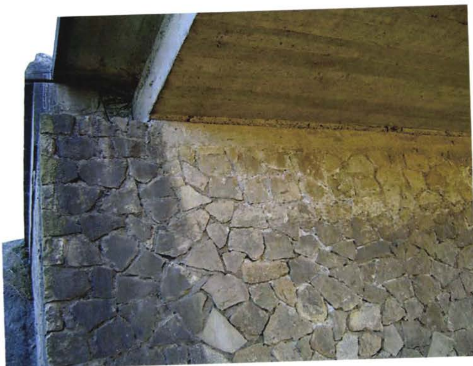
View abutment Nr.1 Vedere culeea Nr.1 Вид устой № 1
