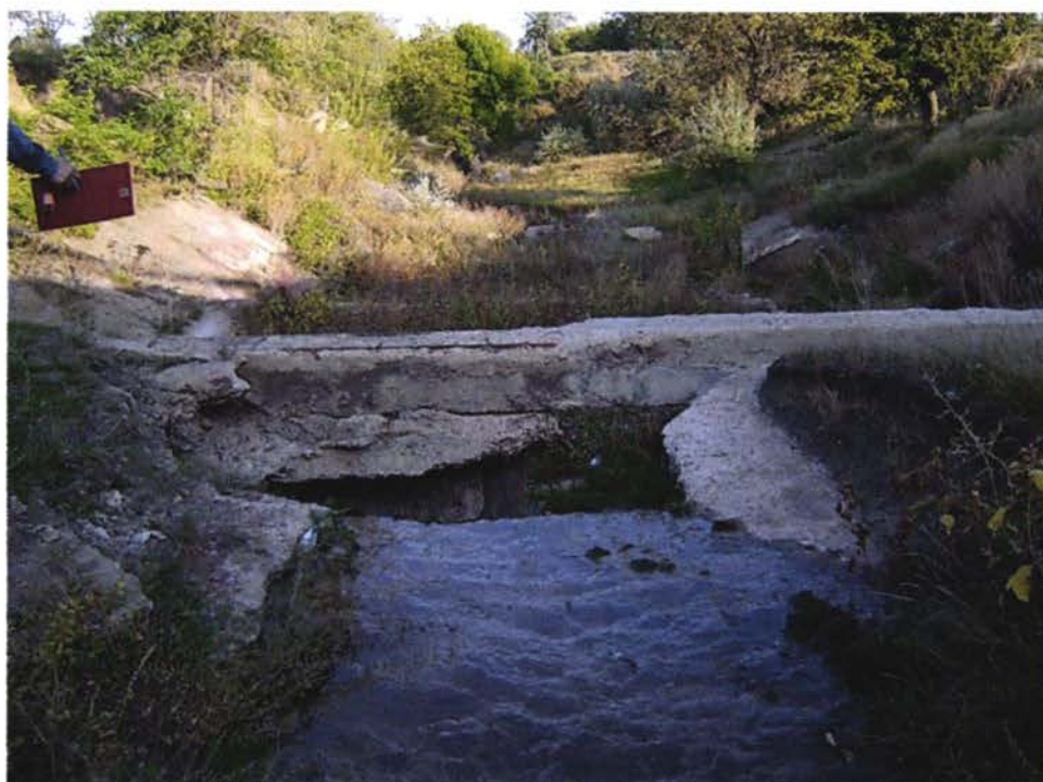
View broadcrested weir (both images) Vedere deversor cu prag lat (ambele imagini) Вид широкого водослива (оба изображения)
