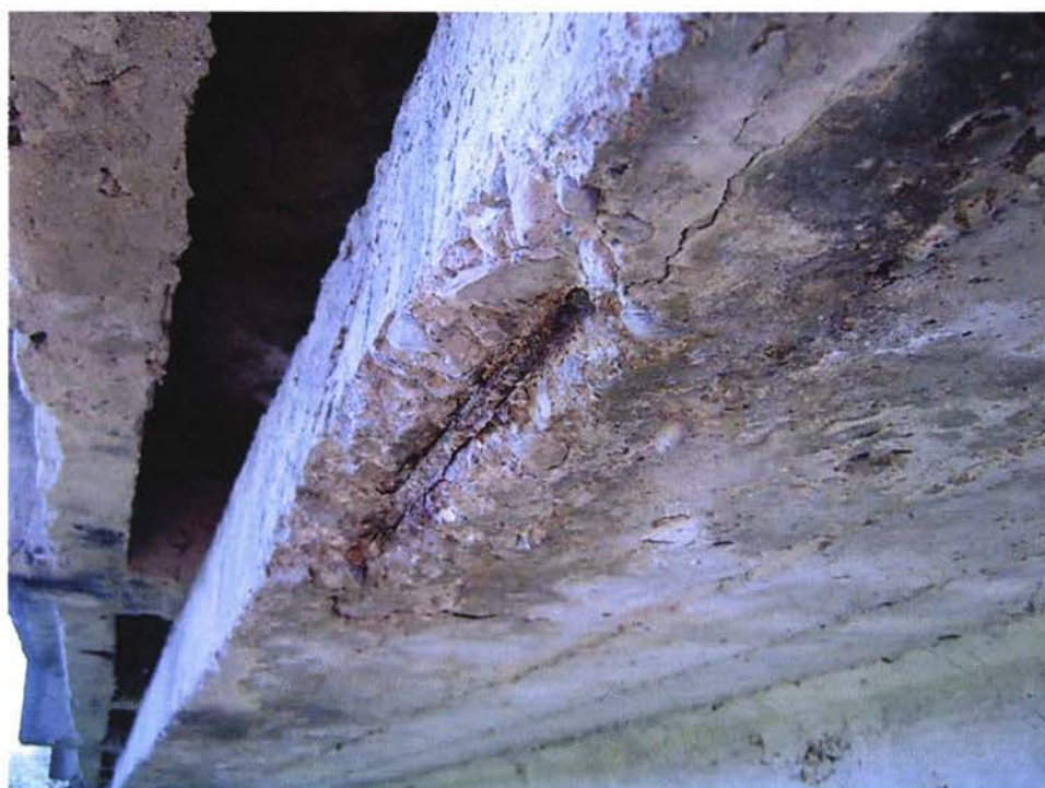
View extreme part of beam Vedere partea marginală a grinzii Вид крайняя часть балки
