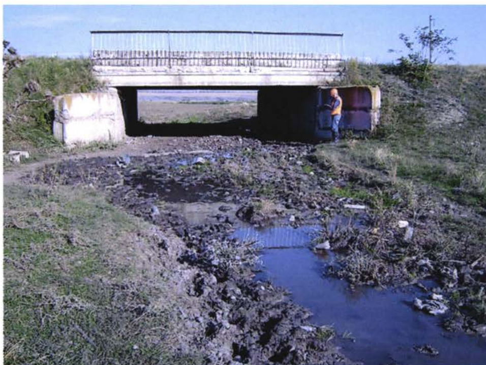
General view of the bridge Vedere generală a podului Общий вид моста
