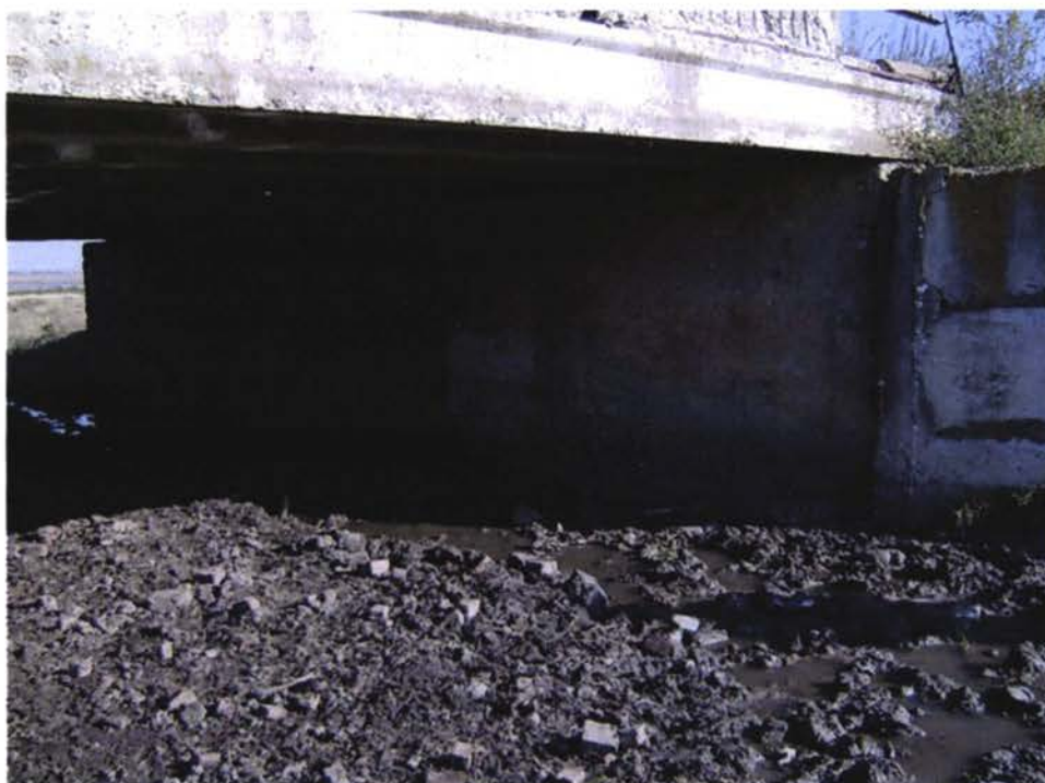
View abutment Nr.2, extended part Vedere culeea Nr.2, partea lărgită Вид устой № 2, уширенная часть
