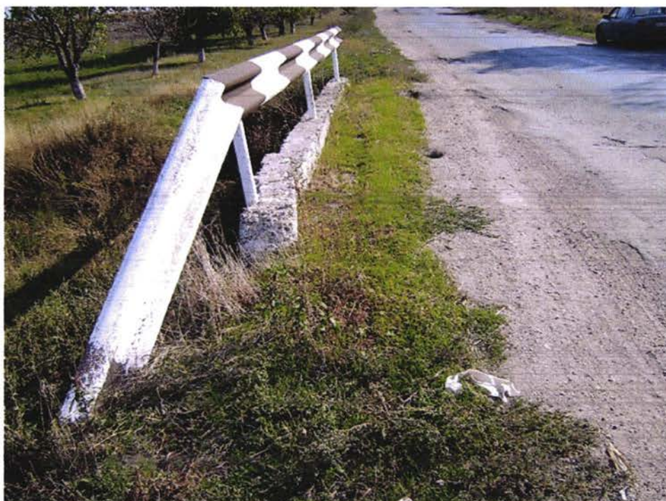
View left enclosure Vedere bariera stângă Вид левого барьерного ограждения
