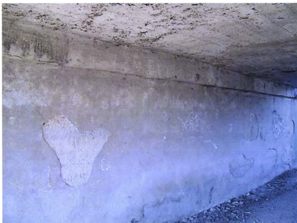
View abutment Nr.1 Vedere culeea Nr.1 Вид устой № 1
