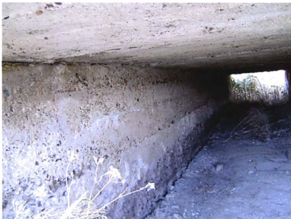
View pier Nr.1 Vedere pila Nr.1 Вид опора № 1
