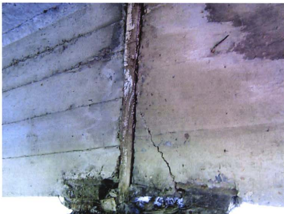
View joint between beams Vedere rostul dintre grinzi Вид шов между балками
