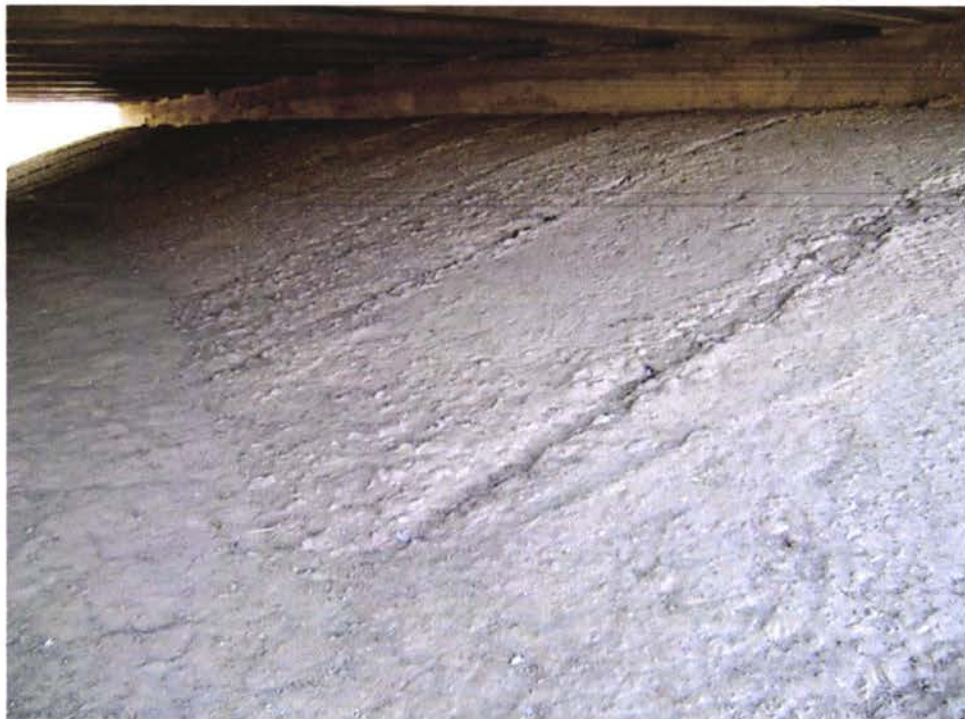
View abutment Nr.2 Vedere culeea Nr.2 Вид устой № 2
