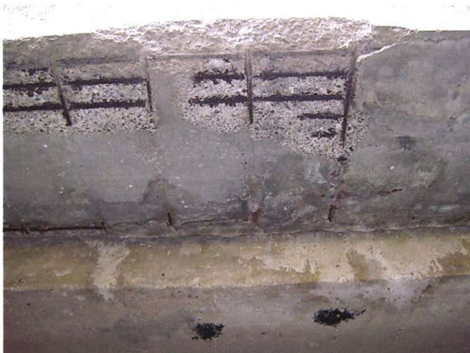
View extreme precast slab, left side Vedere dală prefabricată marginală, partea stângă Вид крайней сборной плиты, левая сторона
