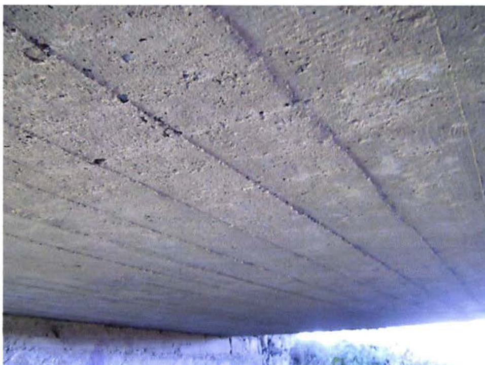
View monolith slab Vedere dală monolită Вид монолитная плита
