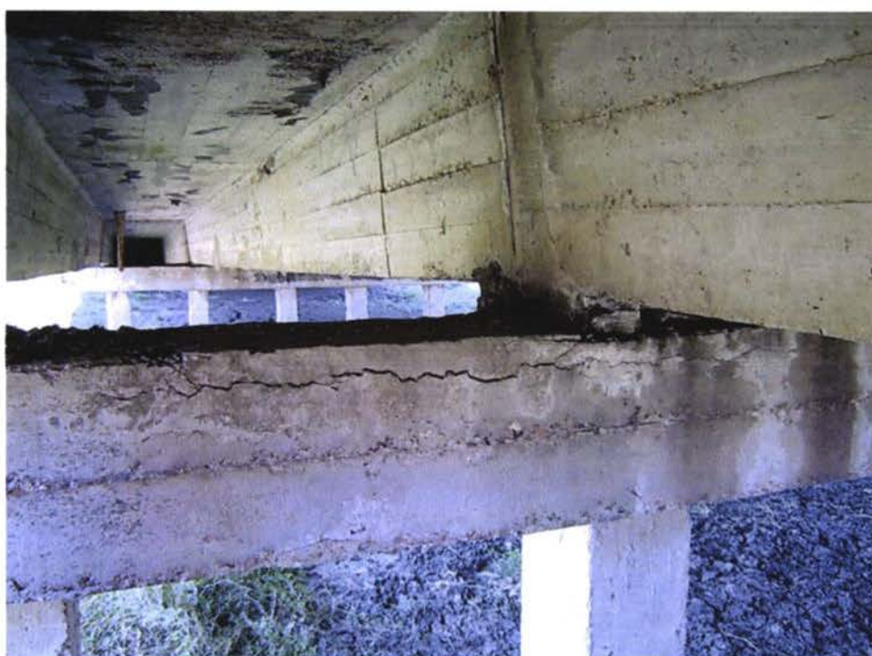
View pier Nr.2 Vedere pila Nr.2 Вид опоры № 2
