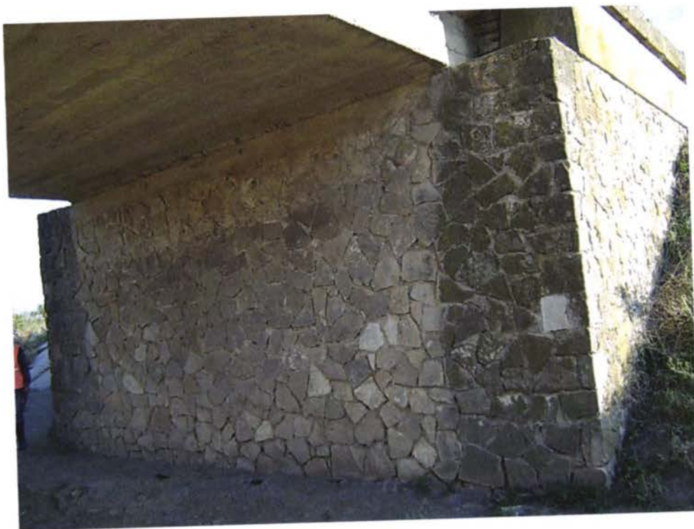
View abutment Nr.2 Vedere culeea Nr.2 Вид устой № 2
