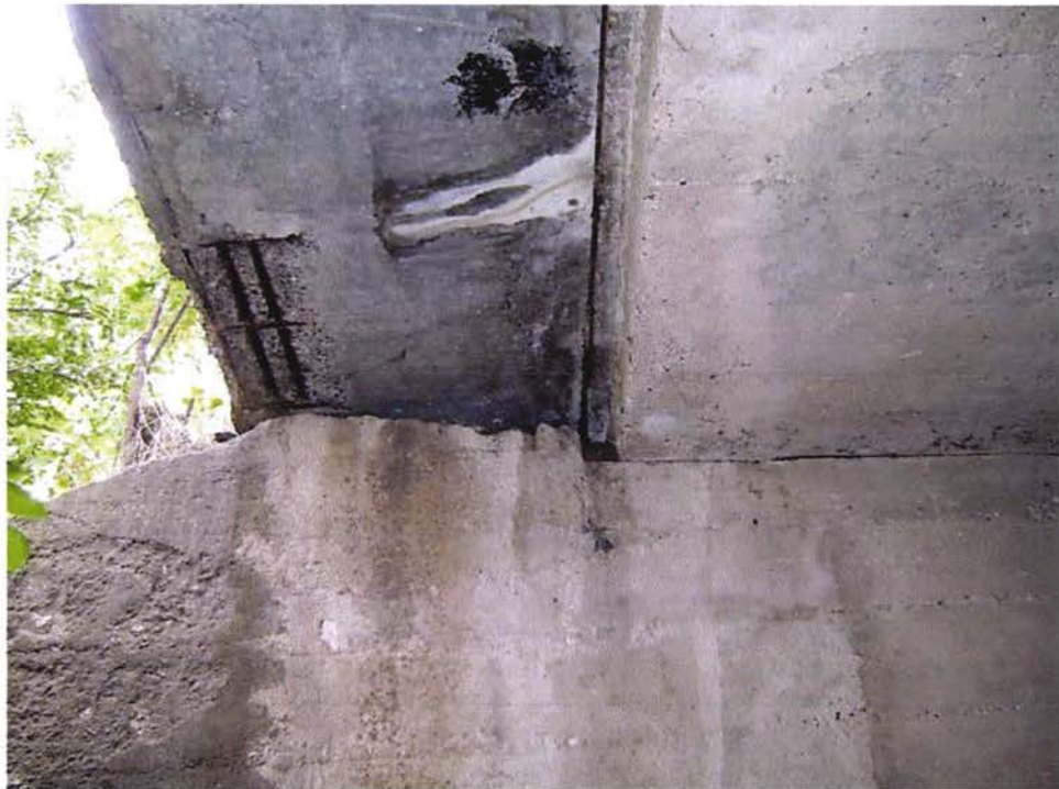
View extreme precast slab, right side Vedere dală prefabricată marginală, partea dreaptă Вид крайней сборной плиты, правая сторона
