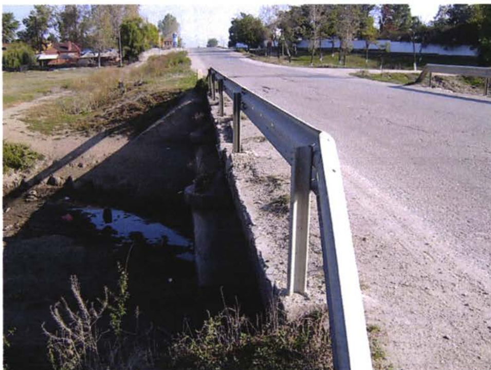
View right enclosure Vedere bariera dreaptă Вид правого барьерного ограждения
