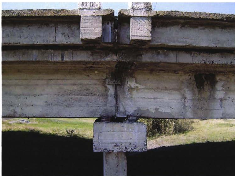
View pier Nr.1 Vedere pila Nr.1 Вид опоры № 1
