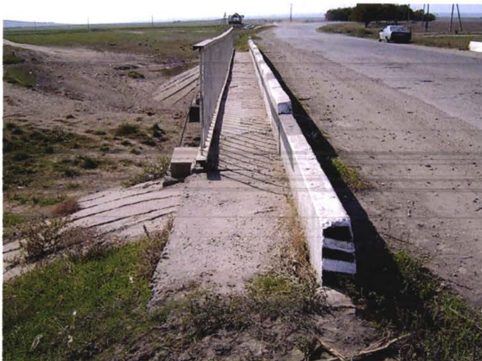
View of left sidewalk Vedere a trotuarului stâng Вид левого тротуара
