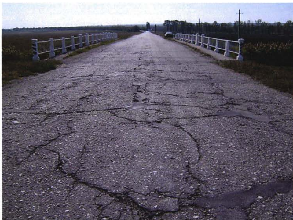
View from direction c. Chişinău, route M-3 Vedere din direcția or. Chişinău, traseul M-3 Вид со стороны г. Chişinău, трасса М-3
