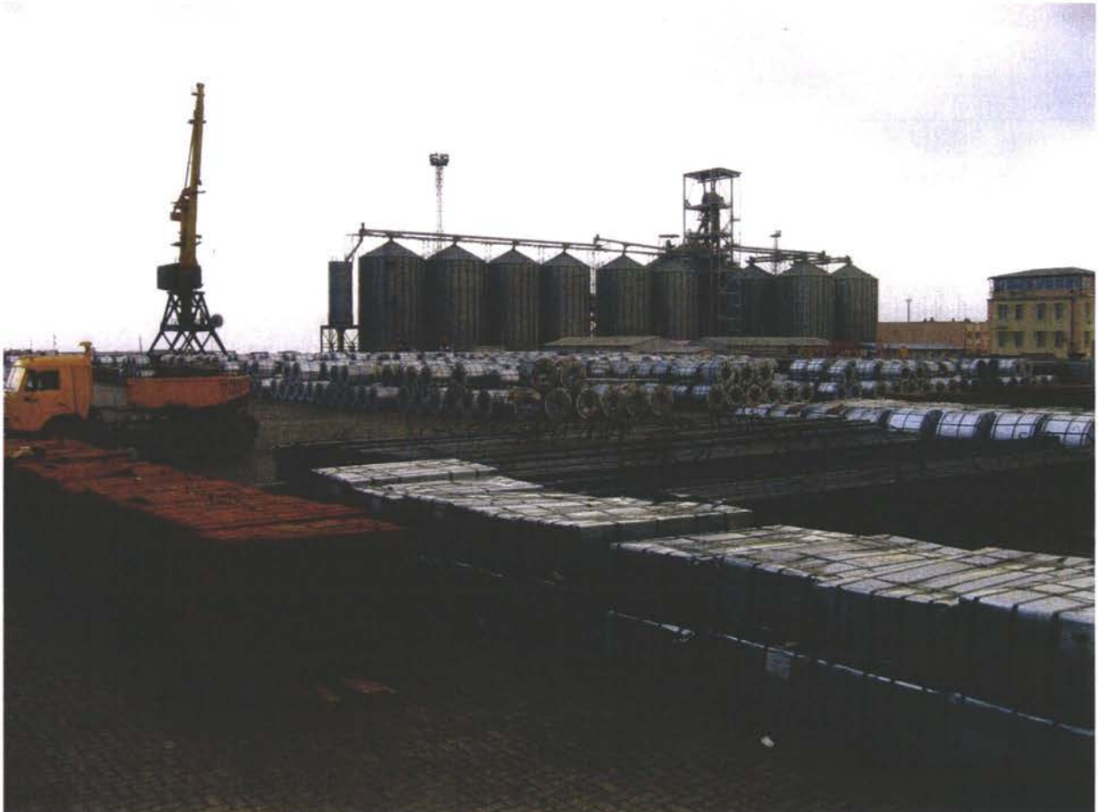
Зерновой терминал и склад для хранения стали позади причалов 1-3
