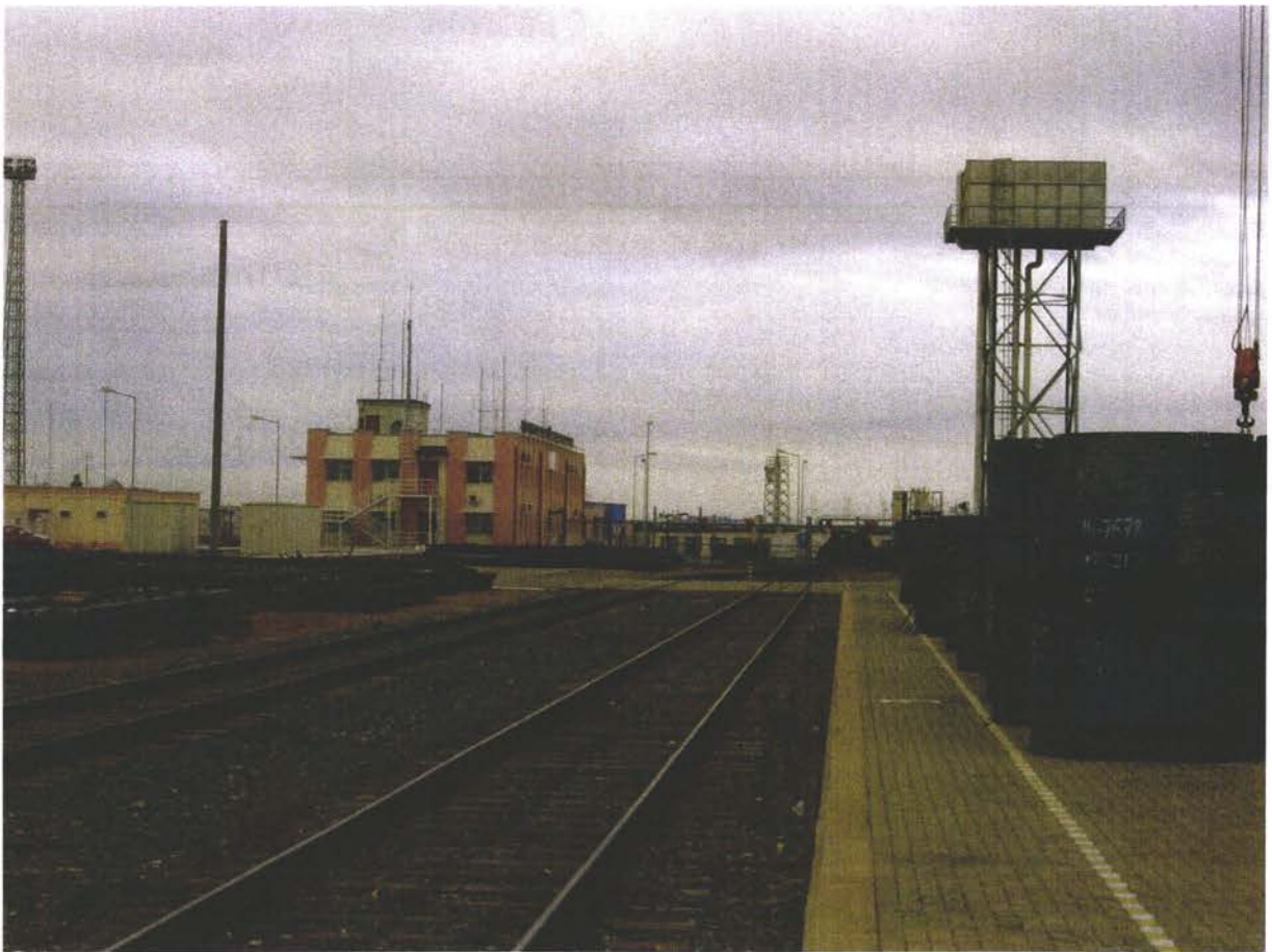
Железнодорожные пути и офис АММТП
