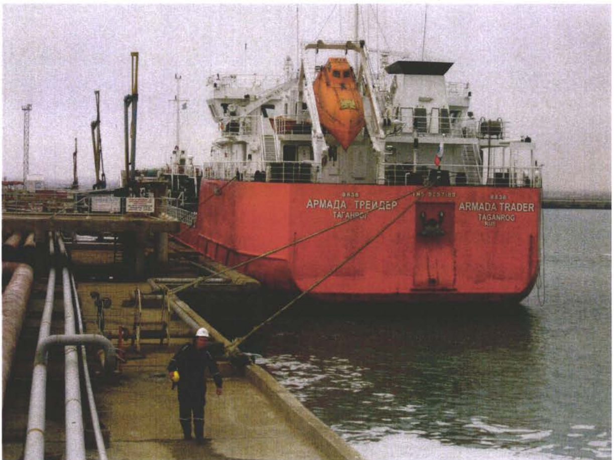
Причалы 9 и 10 (с южной стороны)
