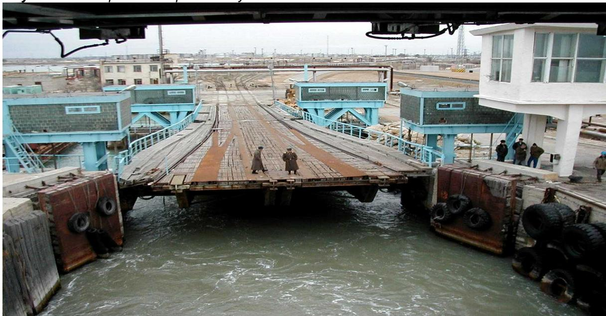
Паромный пирс М8 в порту Актау является универсальным, используемый для приема нефтеналивных танкеров и грузовых судов. В случае перевозки газа, мощность паромного терминала была 448 цистерн в месяц, с учетом использования парома “Советский Дагестан” вместимостью в 28 цистерн. В 2006г. паромный пирс порта Актау был модернизирован для принятия паромов с 56 цистернами. Таким образом, объем транспортируемого газа может быть увеличен до 832 цистерн в месяц.
