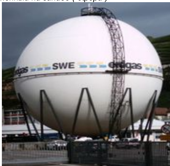
Рисунок 2.2 Резервуары для хранения сжиженного нефтяного газа приблизительно 1,000 МТ - тип, распространенный в СНГ (“сигара”)
