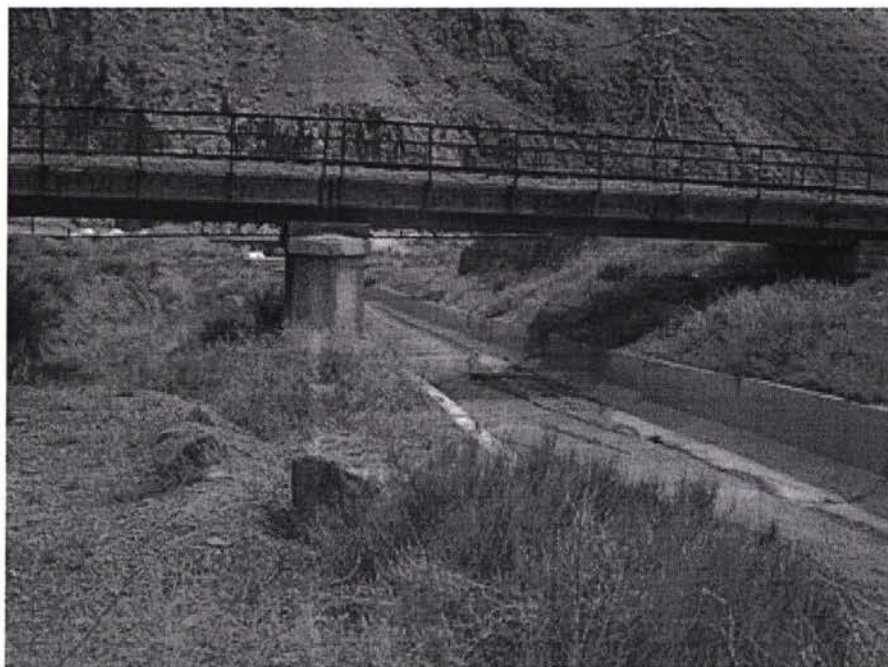
Рис. 2.5 – 2 – Старые железобетонные укрепления вдоль русла реки
