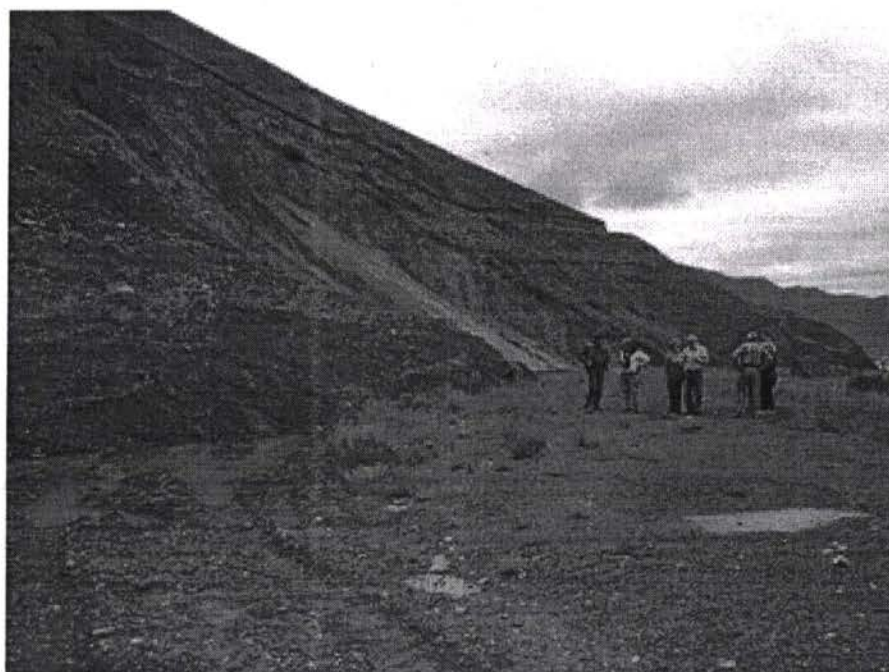
Рис. 2.6 - 3 – Лужи воды на поверхности оползня
