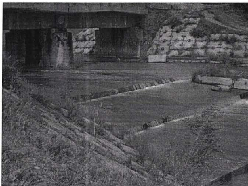
Рис. 2.5 – 3 – Мост на реке Конда
