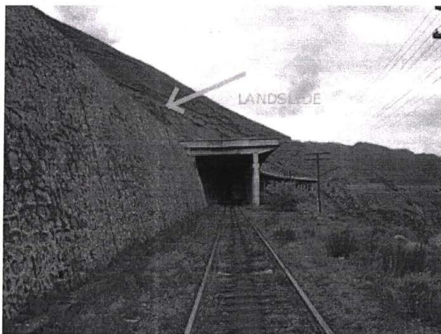
Рисунок 2.6 - 1 – Противолавинная галерея с оползнем на задней части
