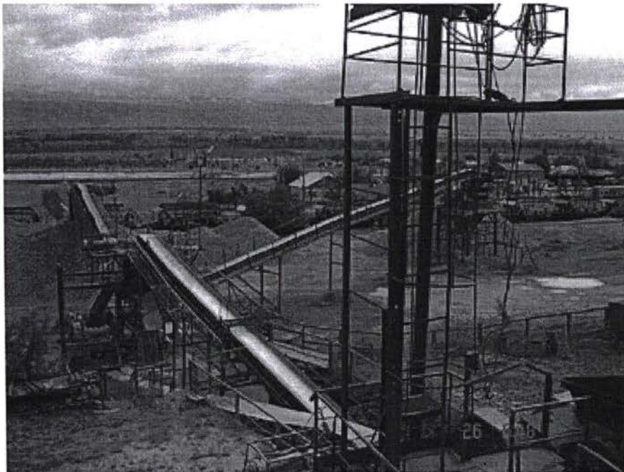
Рис. 2.7 - 2 – Существующий дробильный завод
