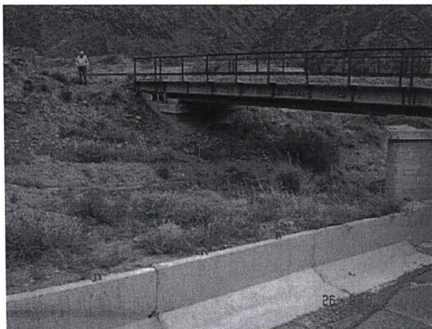
Рис. 2.5 – 1 – Мост после станции Джиль-Арык
