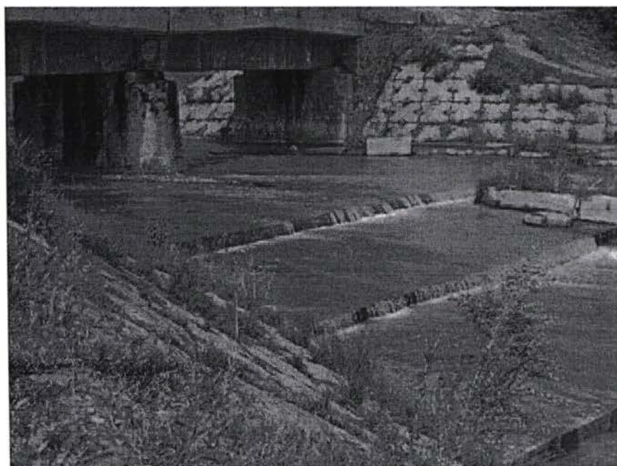
Рис. 2.5 – 3 – Мост на реке Конда
