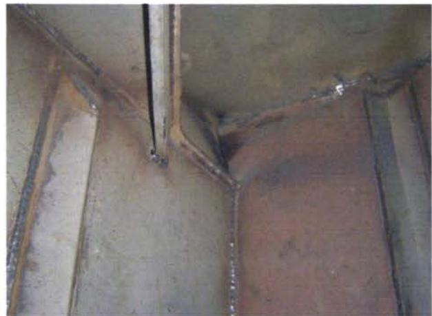
Сварка внутренней обшивки носовой части левого борта
