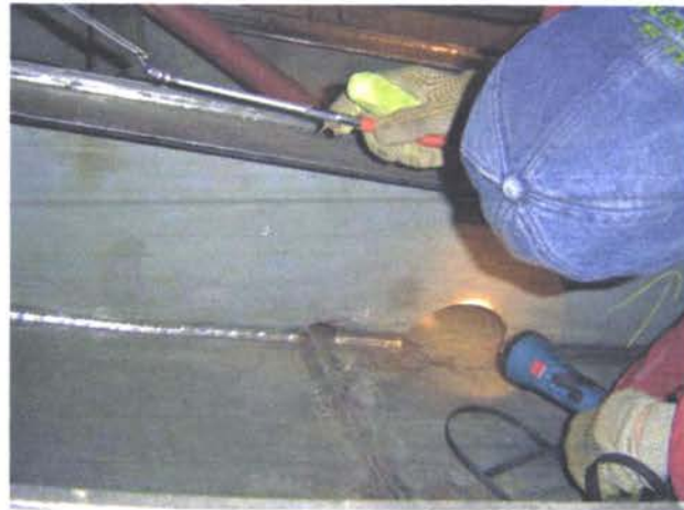
Final check tank Nr 6
