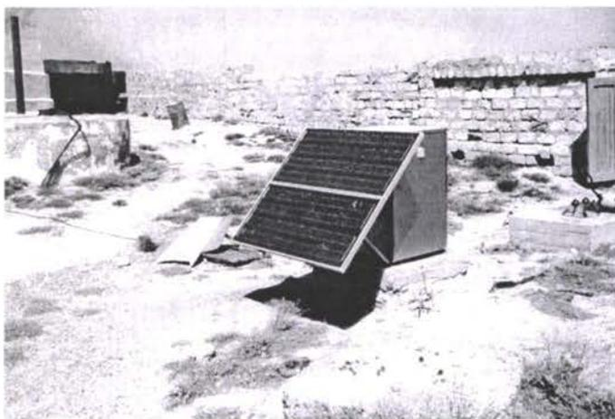
Установка блока питания на земле с кабелями большой длины до фонаря на верхней платформе маяка – слишком большие потери в кабеле и недостаточное количество двух солнечных модулей.
