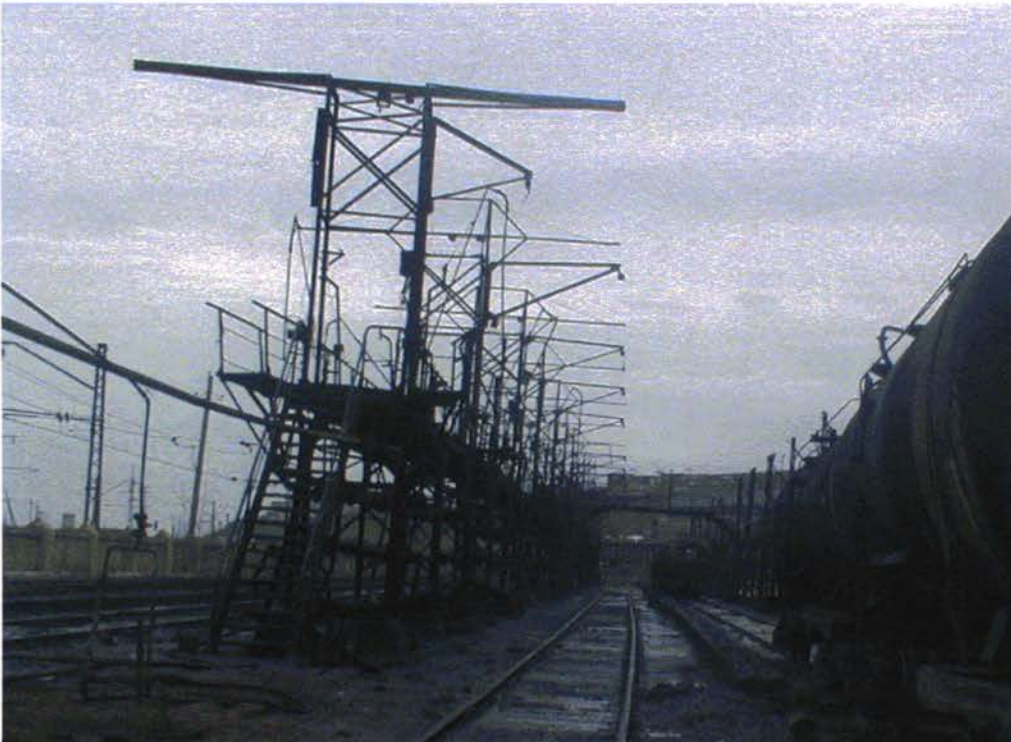
Рисунок 20: Станция очистки железнодорожных цистерн в Биладжарах
