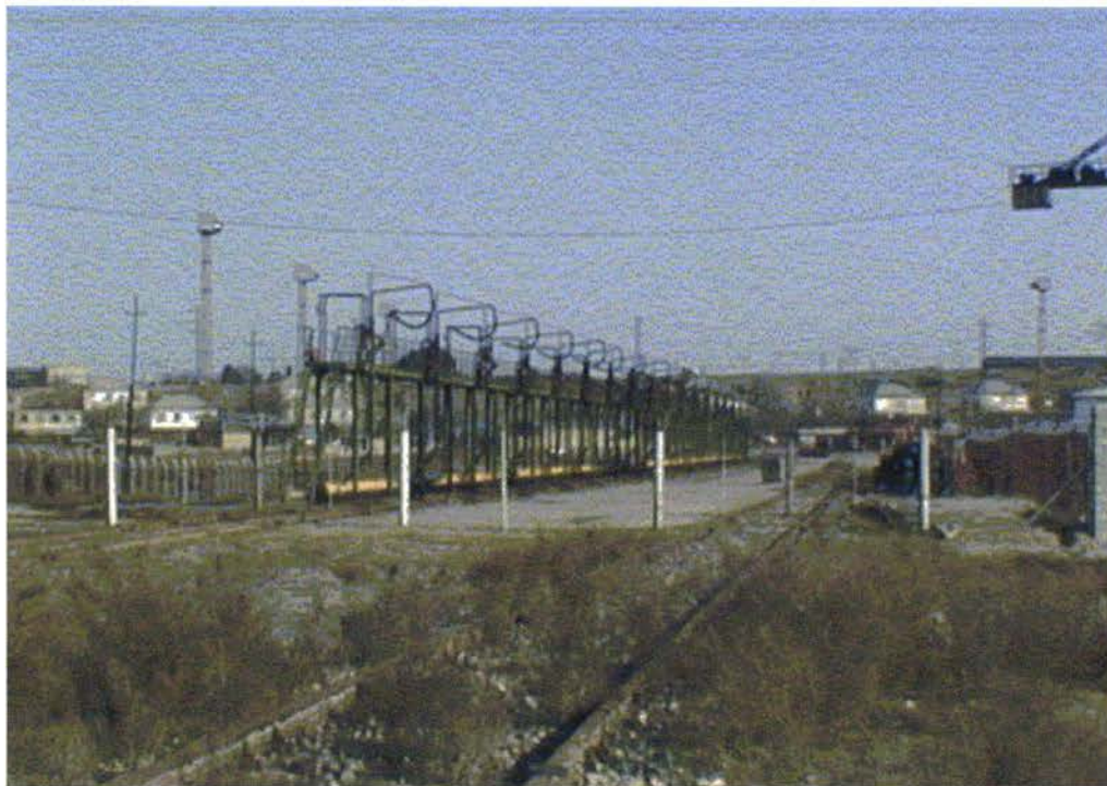
Рисунок 10: Односторонняя эстакада цистерн на станции Али-Байрамлы
