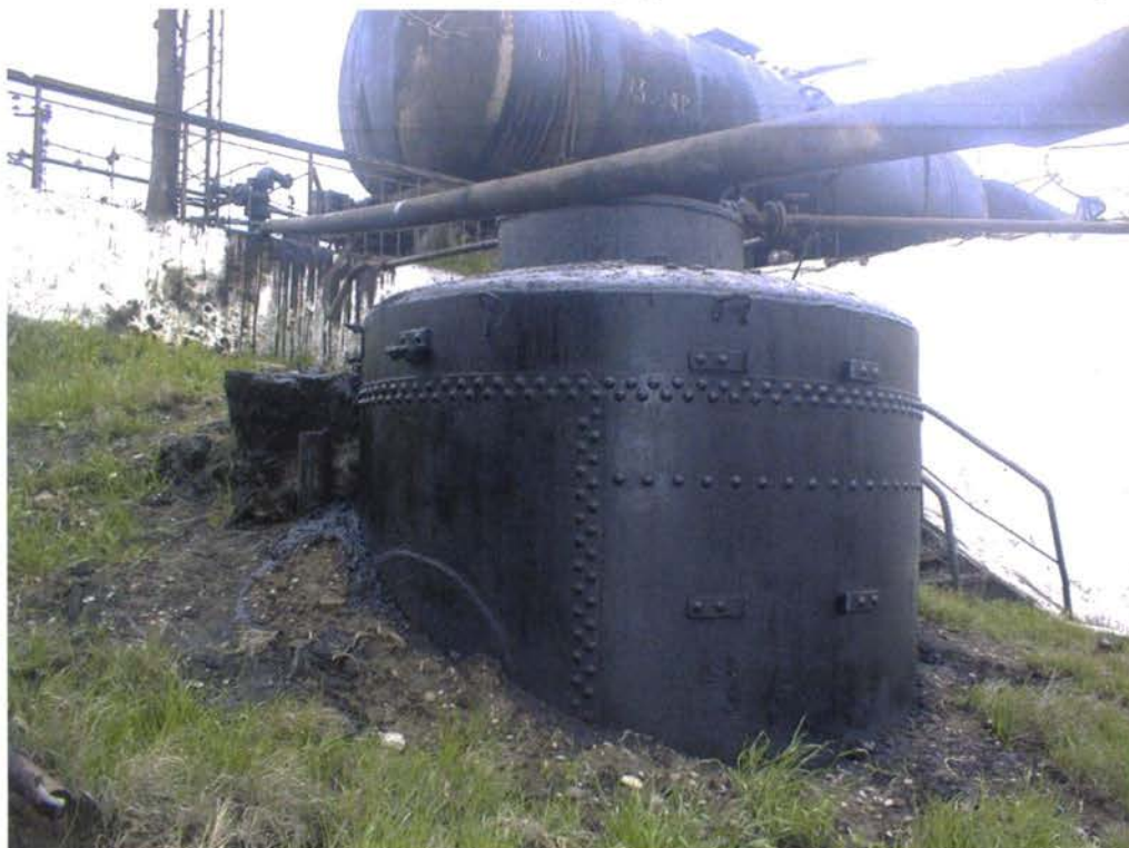
Рисунок 21: Разделительный резервуар на станции очистки цистерн в Баладжарах
