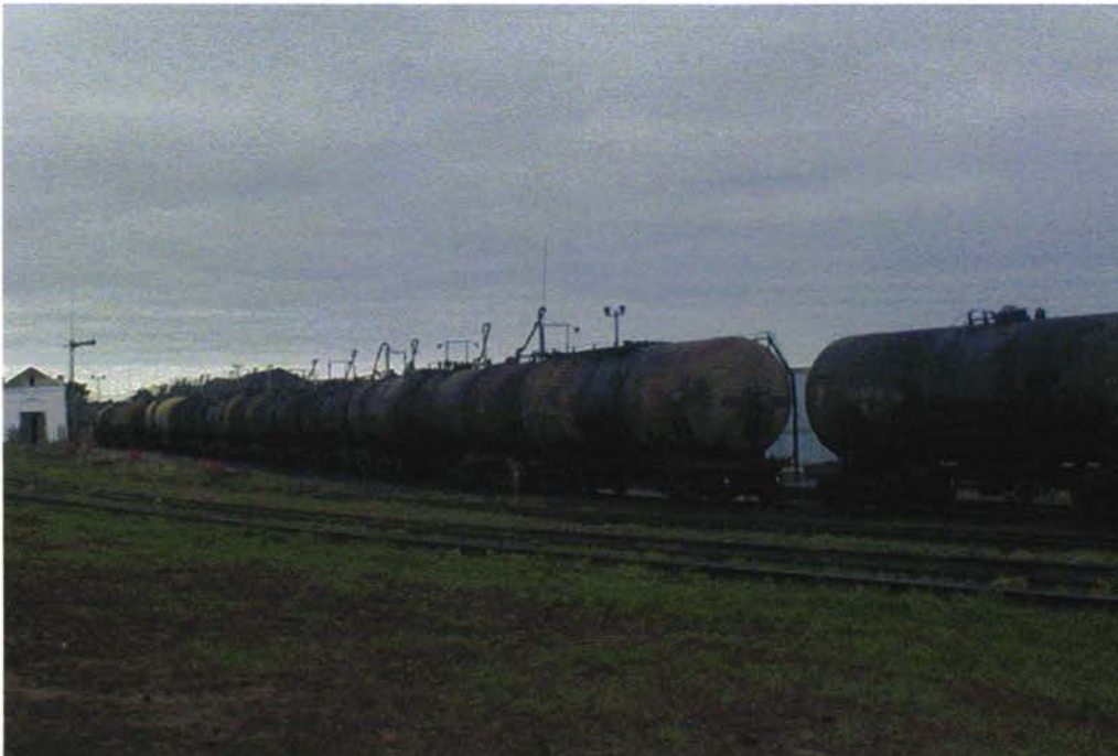
Рисунок 5: Эстакада Ворошилов, в Баку около очистительного завода Азнефтьяг
