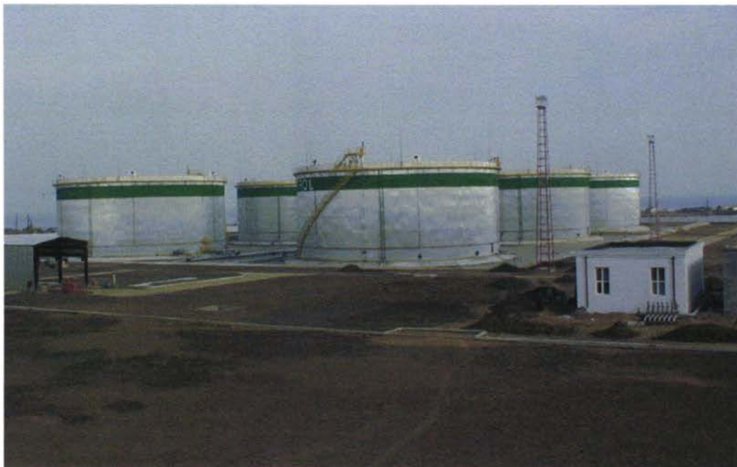
Рисунок 6: Хранилище баков на Терминале Азпетроль Сангачал
