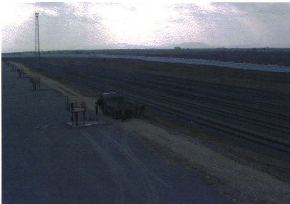
Рисунок 8: Сортировочная станция в районе Азпетроль, Сангачал
