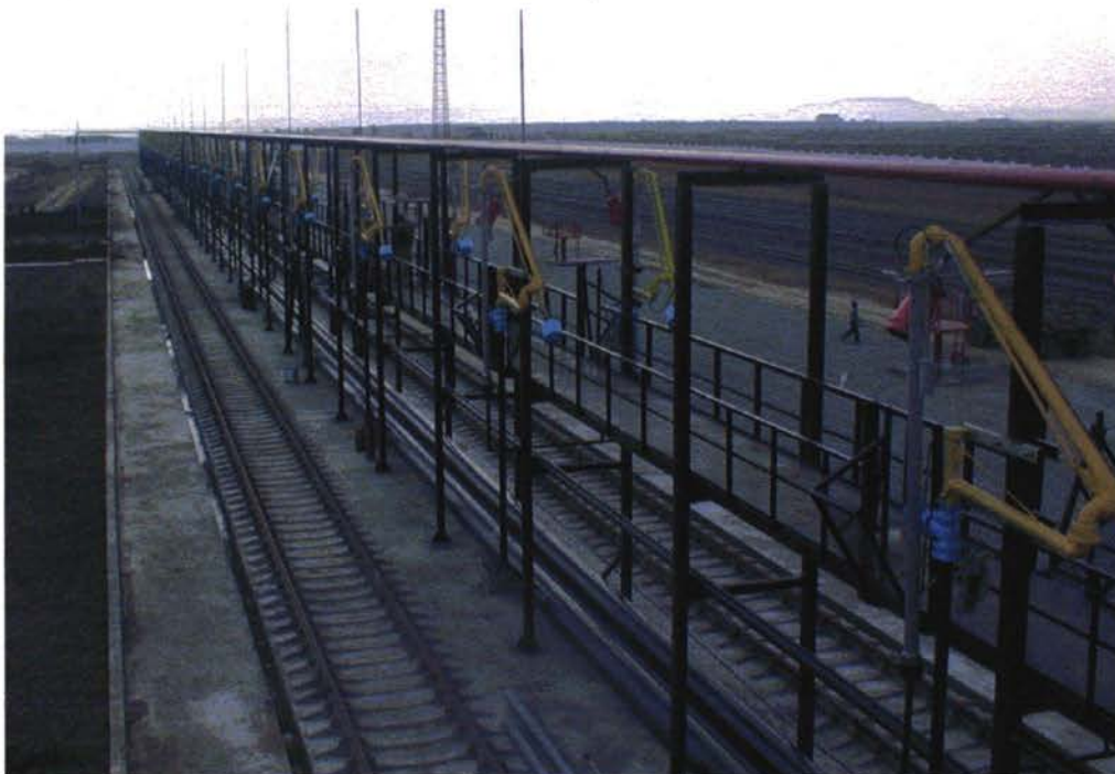
Рисунок 7: Новая эстакада на Азпетроль Сангачал
