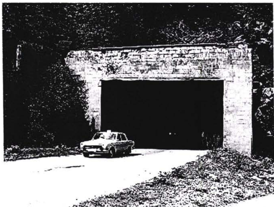
Тоннель 1. Вид Южного Портала
