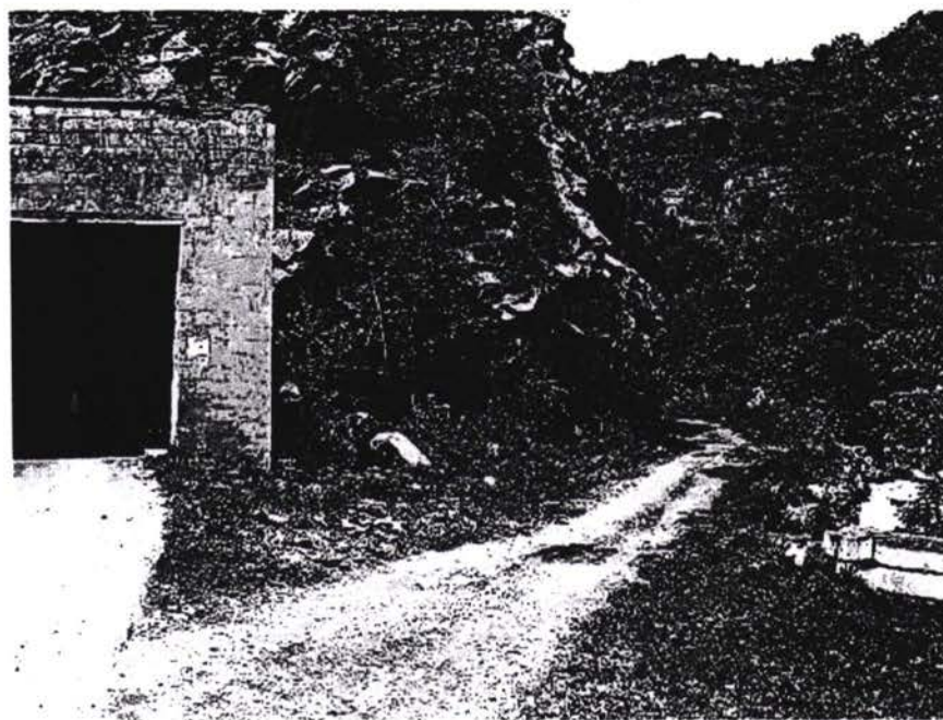
Тоннель 1. Вид боковой дороги у Южного Портала
