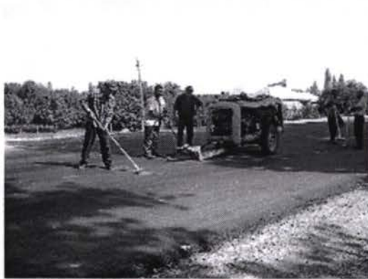
Слой износа в полную ширину
