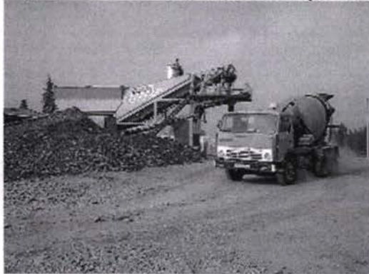
Удалённый асфальт на отвалы грунта на основной площадке и некоторые измельчённые материалы отвала грунта
