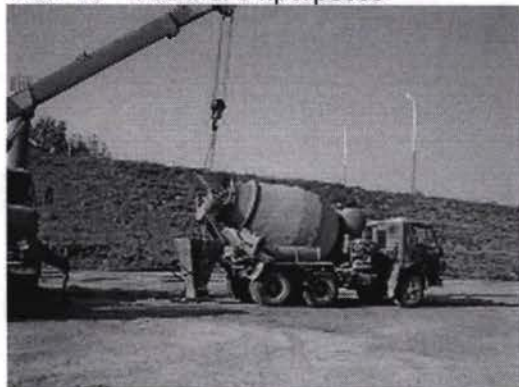
Мост 45 – Работы в процессе
