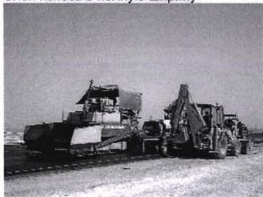
Слой износа в полную ширину
