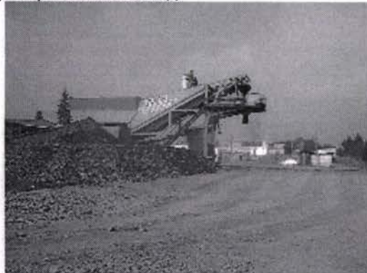
Удалённый асфальт на отвалы грунта на основной площадке и некоторые измельчённые материалы отвала грунта
