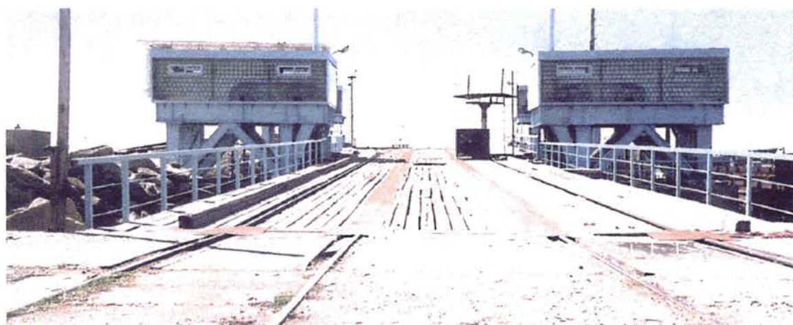
2. Два въездных рельсовых пути, палубная платформа и внутренние подъемные башни.
