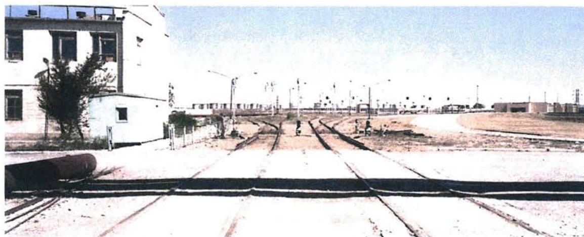
3. Паромная железнодорожная станция (морской порт) и бывшее железнодорожное здание (на левой стороне).
