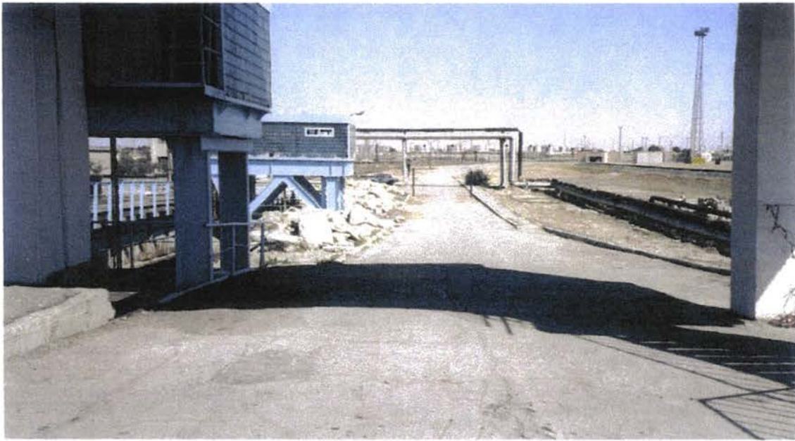
23. Въездной путь к центральному пирсу.
