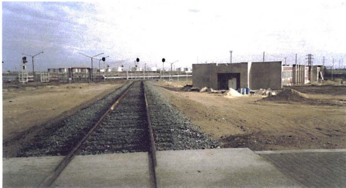
24. Пассажирский терминал в процессе восстановления.
