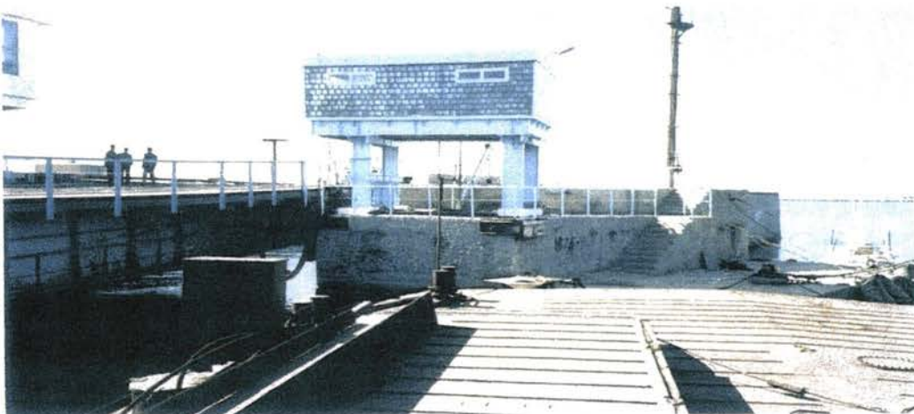
20. Внешняя подъёмная башня (на правом борту).
