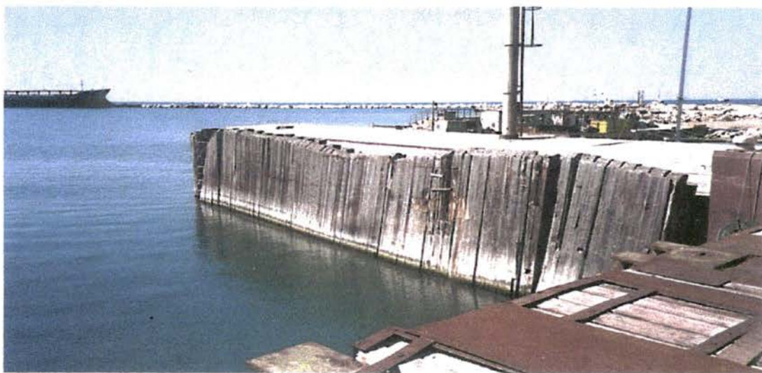
11. Деревянная предохранительная рама на пальцевидном пирсе.
