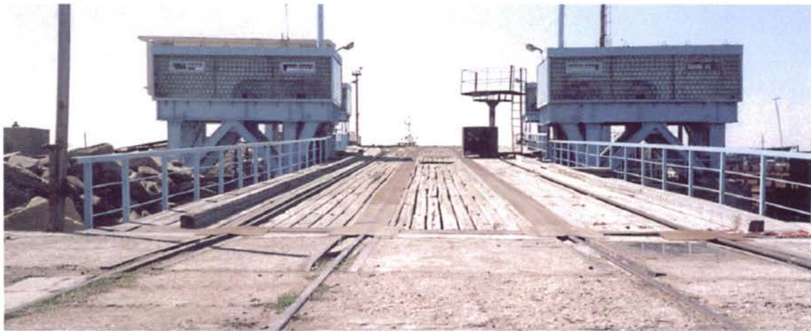
2. Два въездных рельсовых пути, палубная платформа и внутренние подъёмные башни.
