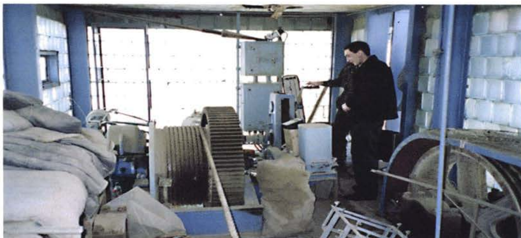
21. Внутри внешней подъёмной башни.
