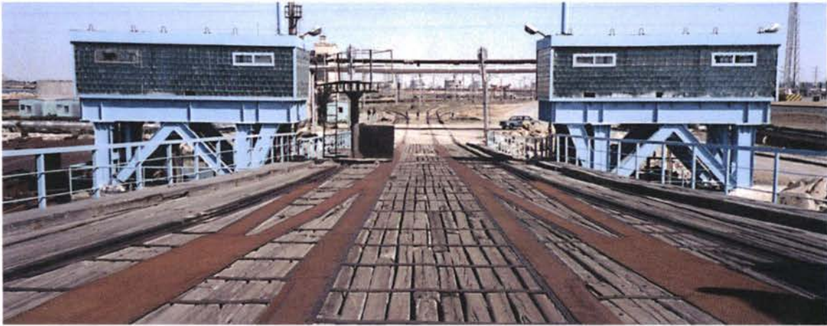
1. Палубная платформа и внутренние подъёмные башни (Надземные нефтяные и водяные трубы).
