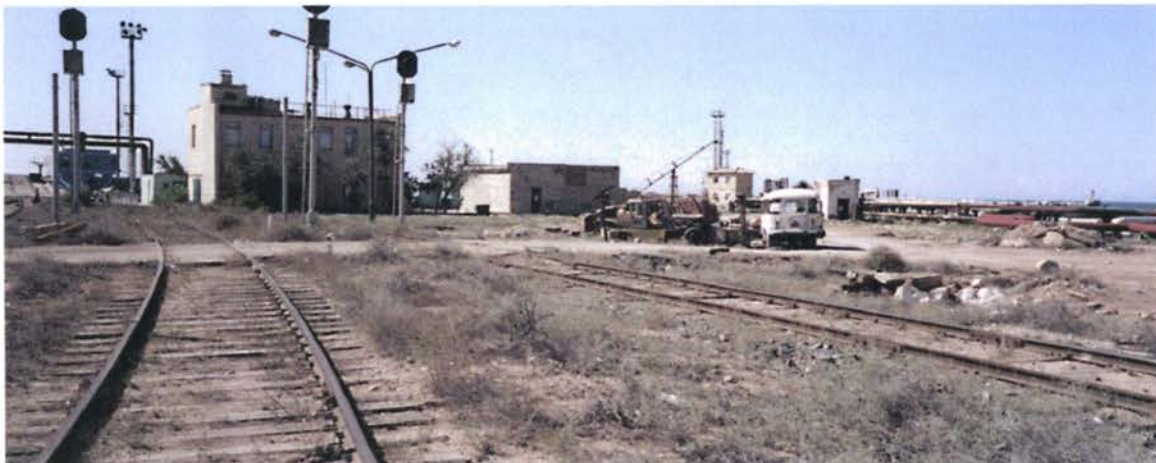
5. Контрольное здание железнодорожной станции морского порта и трансформаторная подстанция ТР 803.
