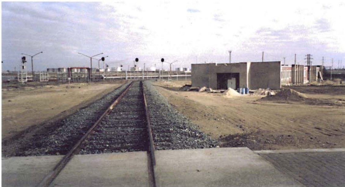
24. Пассажирский терминал в процессе восстановления.
