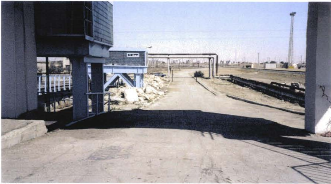
23. Въездной путь к центральному пирсу.
