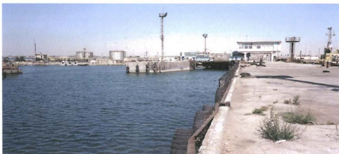
10. Повреждённая мостовая центрального пирса.
