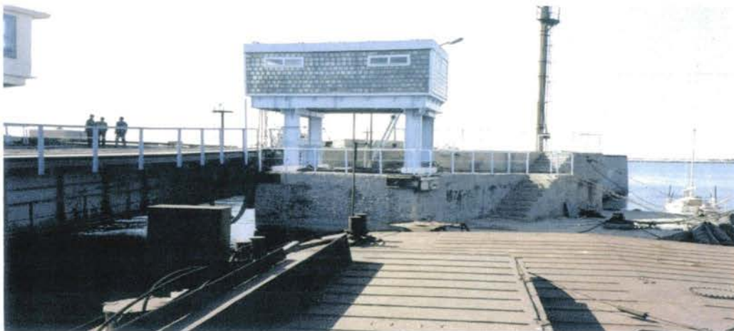
20. Внешняя подъёмная башня (на правом борту).
