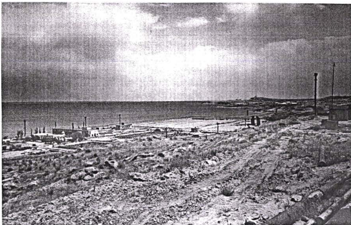
20.3. Дубендинский завод очистки сточных вод
