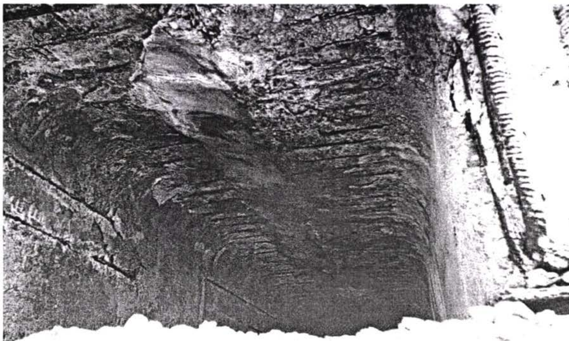
4.5. Дубенди. Бетонная суперструктура пирса
