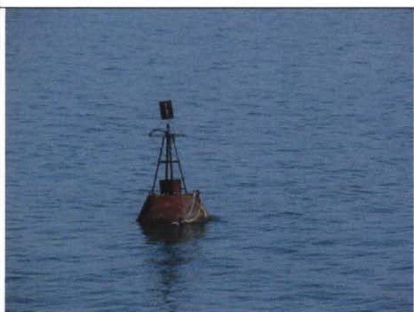
Буй без радарного рефлектора, цвет неузнаваемый, должен быть красным.
