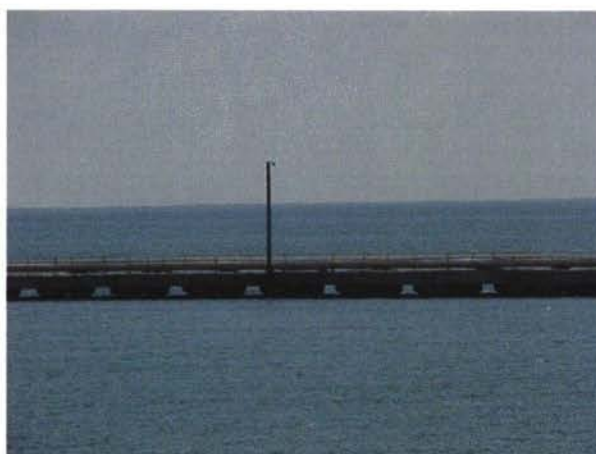
Трубопровод к нефтяному терминалу с волнорезами с юга
