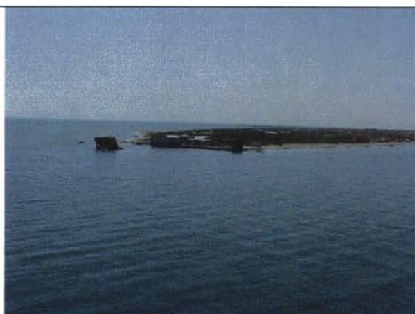
Разрушения при приближении к каналу Туркменбаши.
