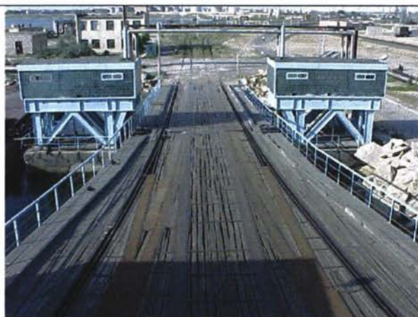
RoRo скат в Актау, рельсы покрыты древесиной, железнодорожные операции невозможны
