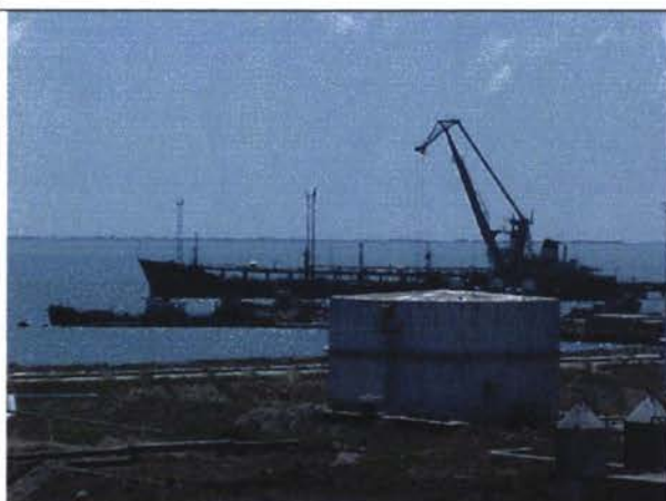
Вид с Административного Здания на пирс 3 и причал 4
