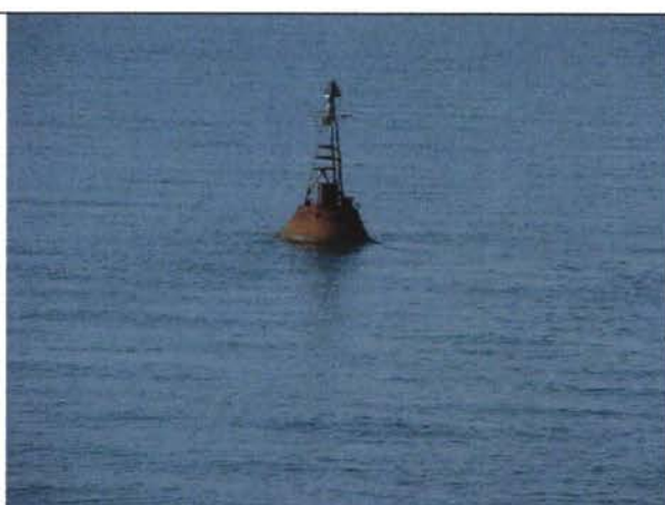
Буй без радарного рефлектора, цвет неузнаваемый - должен быть зелёным или чёрным.
