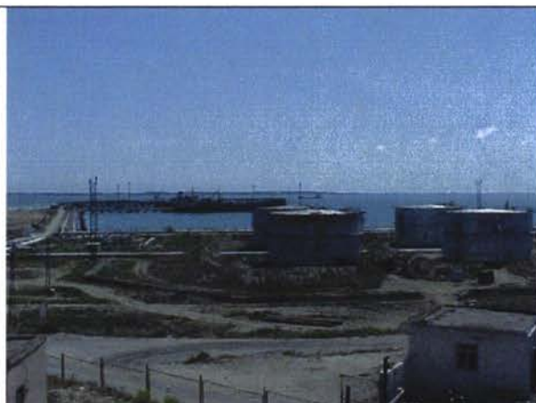
Вид с Административного Здания на пирсы 1, 2, 5 и цистерны
