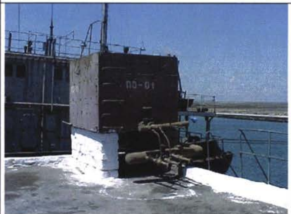
Цистерна для пены на пирсе 1, для борьбы с пожаром.
