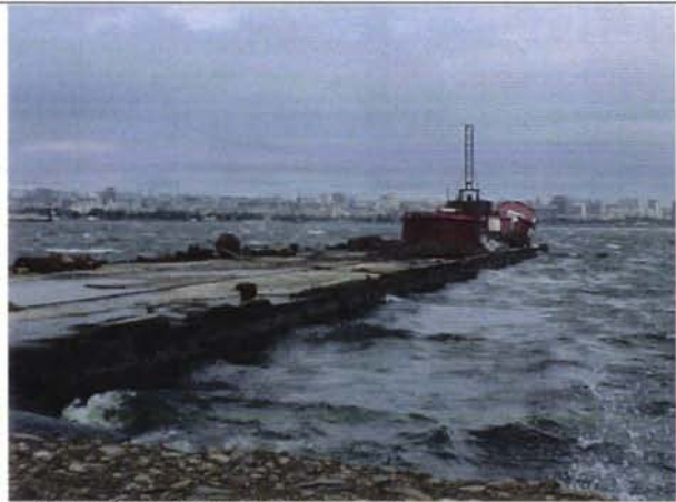
Цех обслуживания и ремонта, гидрографическая служба военно-морского флота Азербайджана, вид с причальной стенки на участок с буюми
