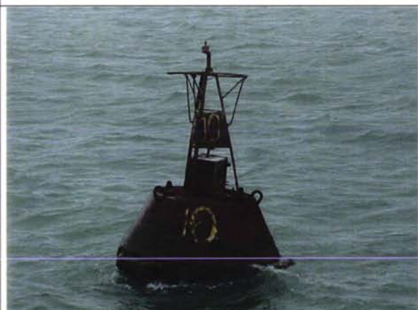
Портовый буй 10, без топовой фигуры и с почти отсутствующим красным покрытием, с поврежденной ограждающей решеткой
