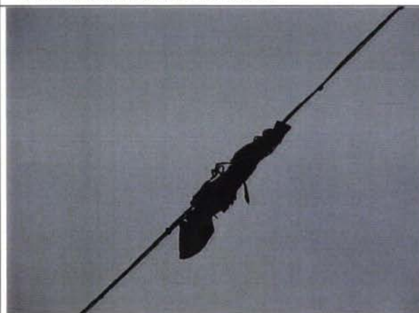
Электрокабель после ремонта
