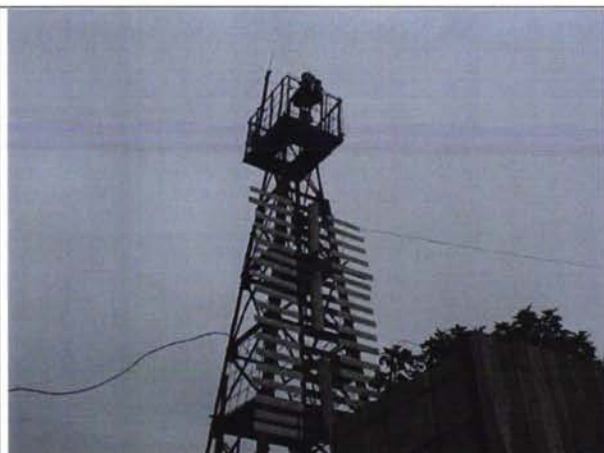
Бакинская башня створных огней 1: Обзор с юго-западной стороны с видом на электрический питающий кабель
