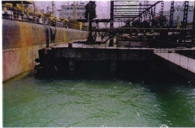
16. Head section of pier n°3
