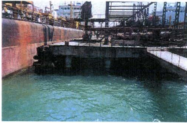
16. Head section of pier n°3
